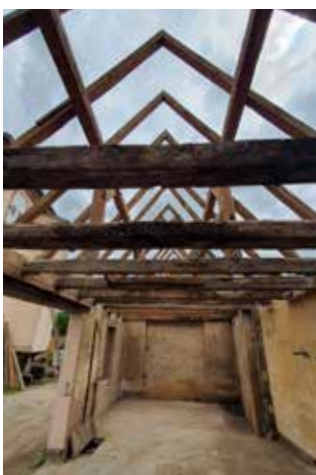
Dépose des tuiles et des plafonds réalisée par les bénévoles
