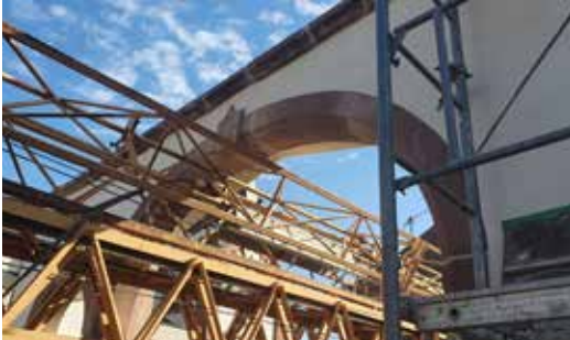
2mm de jeu en haut du portail et seulement 2 mm en bas, chapeau aux deux spécialistes Maxime et Antoine qui ont manœuvré la grue le 29 septembre pour la placer dans la cour du presbytère.
